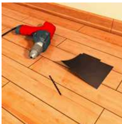
1. Abkleben der Hohlstelle
