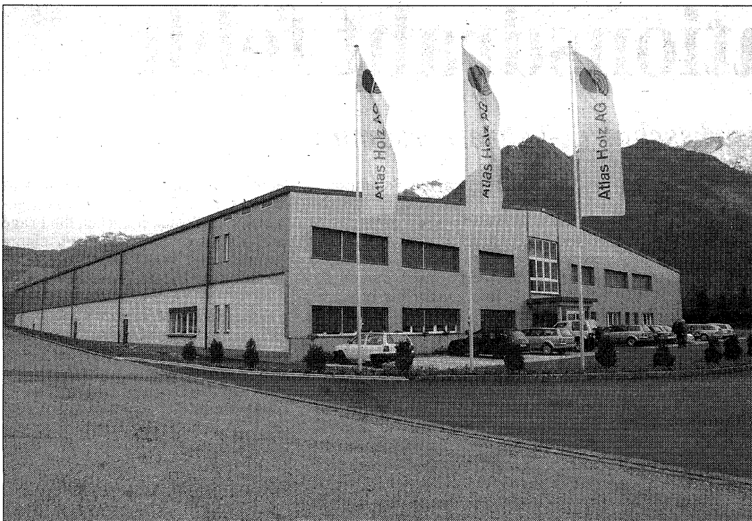
Neu erstellte Räumlichkeiten der Atlas Holz AG: Das Gebäude steht an der Fährhüttenstrasse 1 in Trübbach.
