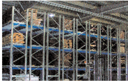
Automatisches Hochregallager, vom Stapler aus steuerbar.
